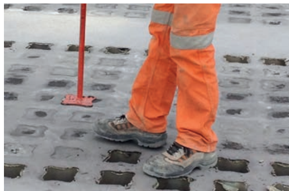
Photo 72 - Désoperculage du système ViaVerde®.
