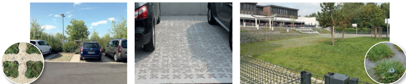
Photos 22 à 24 - Exemples diversifiés d'emploi de solutions de revêtements avec système constructif à ouvertures de drainage.
