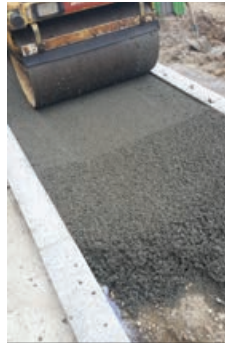
Photo 55 - Compactage du béton drainant.
