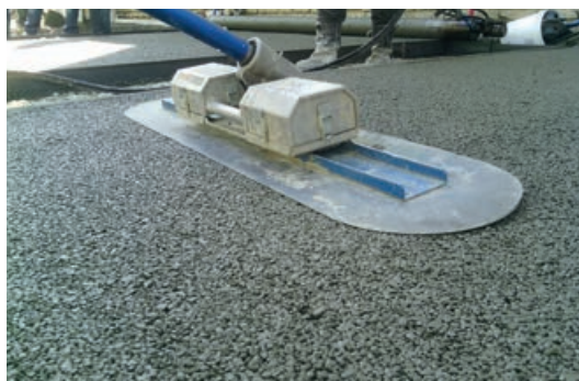
Photo 51 - Passage de la lisseuse vibrante.
