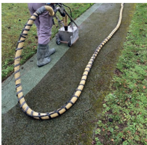
Photo 94 - Nettoyage par pression d'eau suivi d'aspiration.
