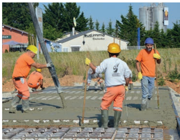
Photo 68 - Coulage du béton sur les moules ViaVerde®
