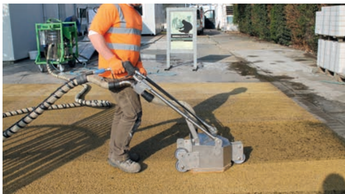
Photo 97 - Décolmatage d'un revêtement en béton drainant à l'aide d'un nettoyeur Moby Cline®.
