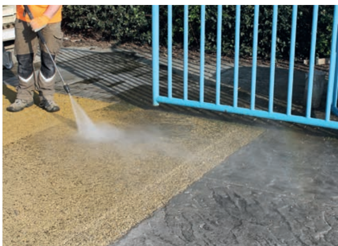
Photo 93 - Lavage au nettoyeur haute pression.
