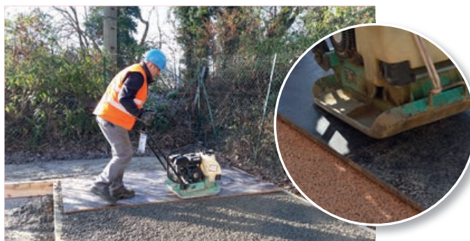
Photo 53 - Compactage au patin vibrant.
