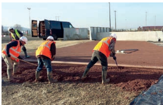
Photo 52 - Nivellement au roller-striker.
