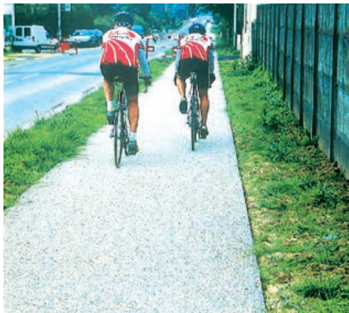
Photo 43 - Une piste cyclable en béton drainant associée à une tranchée drainante en grave naturelle assurant les fonctions hydrauliques
