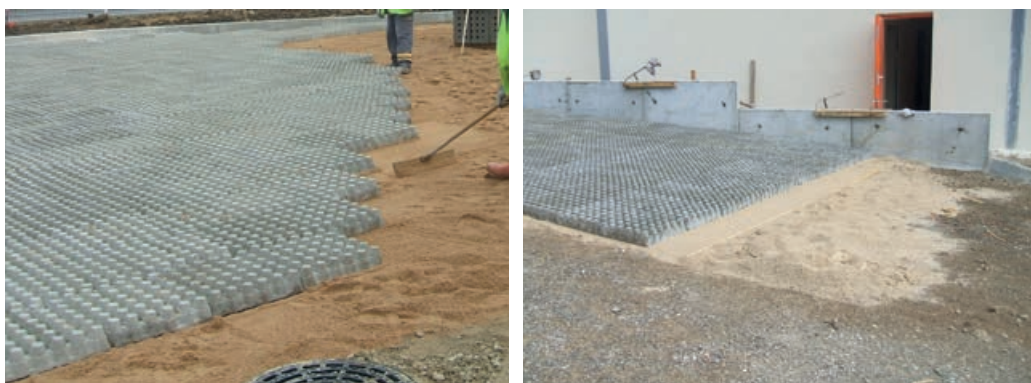
Photos 84 et 85 - Pose de dalles drainantes sur lit de sable.
