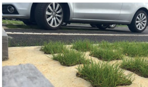
Photo 74 - Engazonnement des alvéoles (système ViaVerde®).
