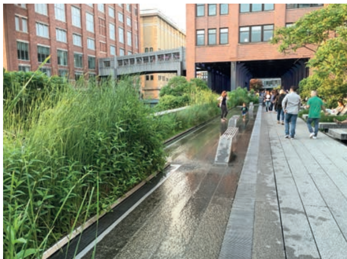
Photo 15 - Passage en produits préfabriqués avec brumisateurs.
