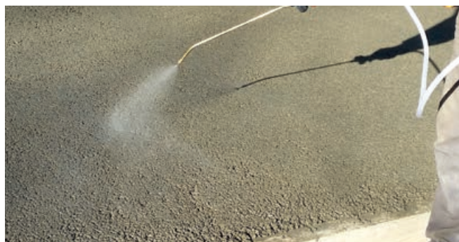
Photo 58 : Protection du béton drainant à l'aide d'un produit de cure spécifique.
