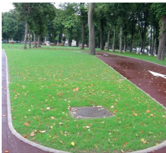
Photo 87 - Revêtement en dalles drainantes engazonnées.
