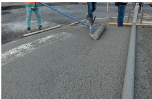
Photo 50 - Compactage au rouleau lesté.
