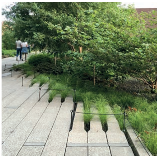
Photo 6 - Nœue paysagère associée à un revêtement en produits préfabriqués.
