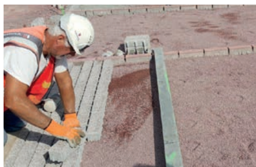
Photo 76 - Le poseur évolue sur la surface déjà réalisée.
