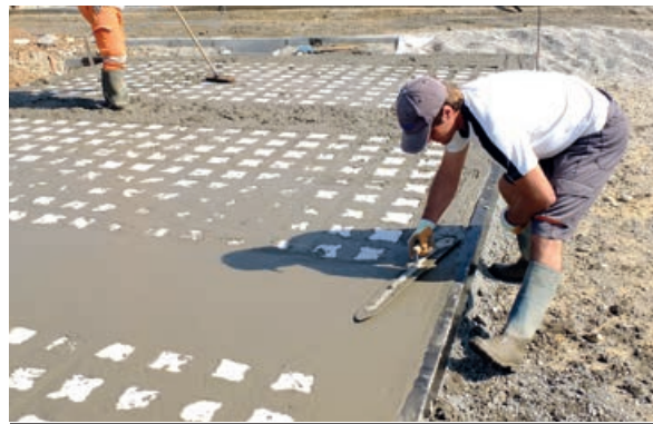
Photo 70 - Talochage du béton (système ViaVerde®)
