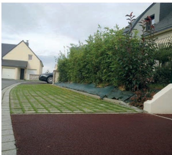
Photo 86 - Places de parking en pavés à joints larges engazonnés.
