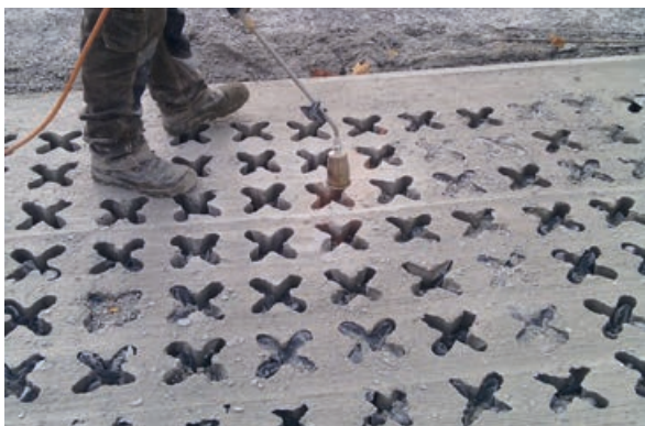
Photo 71 - Utilisation d'un chalumeau à gaz pour faire fondre le moule en plastique (système Grasscrete®).
