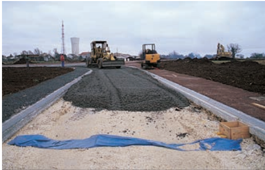
Photo 54 - Répandage du béton drainant à la niveleuse.
