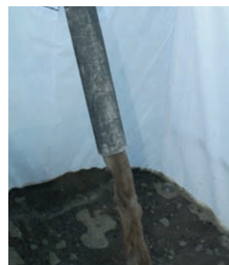
Photo 101 - La boue est récupérée dans des bacs.
