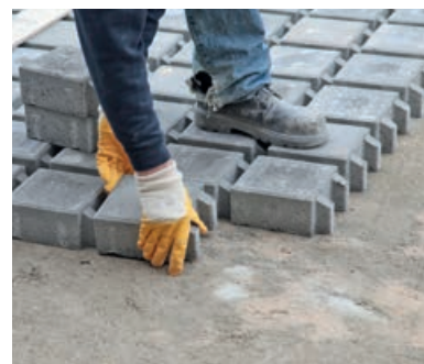
Photo 80 - Le poseur se place sur les produits déjà posés.
