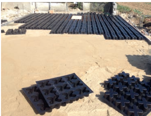
Photo 64 - Pose des moules (système Grasscrete®).
