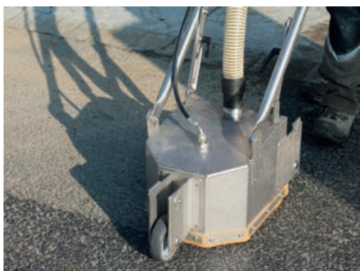
Photo 99 - Le nettoyeur injecte de l'eau sous pression.
