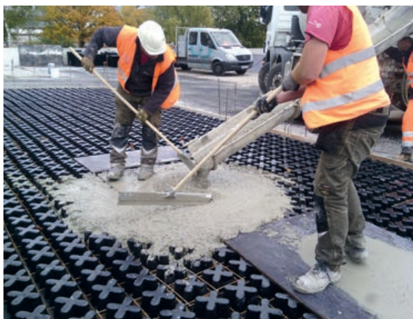
Photo 67 - Coulage du béton sur les moules Grasscrete®
