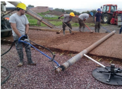
Photo 46 - Coulage du béton et réglage au « roller-striker ».
