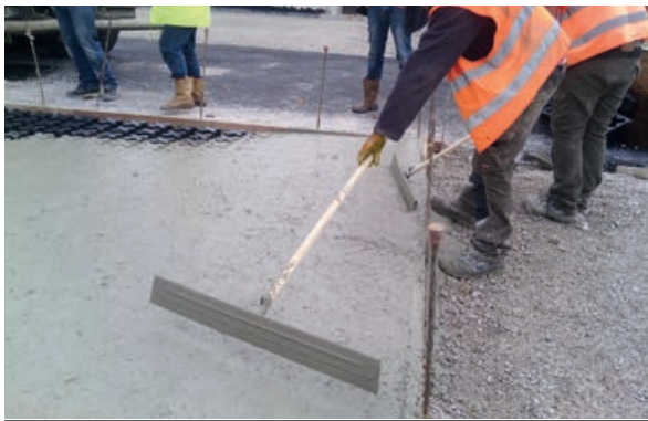
Photo 69 - Répandage à la raclette (système Grasscrete®)
