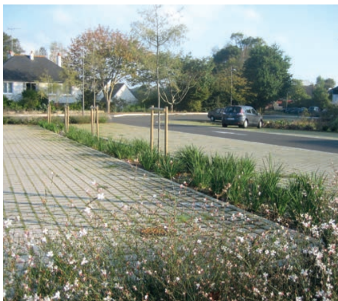
Photos 31 - Aménagement urbain en pavés à joints larges engazonnés, couplé avec une noue paysagère.
