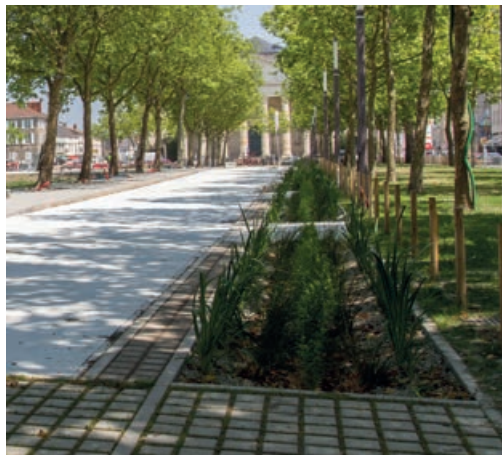
Photo 44 - Revêtement drainant en pavés à joints larges couplé à un réseau de noues.
