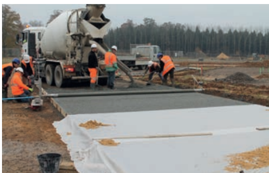
Photo 57 : Protection du béton drainant à l'aide d'un film en polyéthylène.
