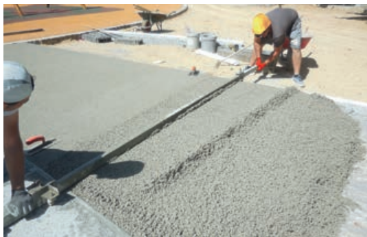
Photo 48 - Nivellement à la règle manuelle.
