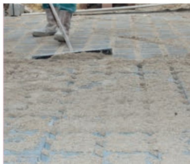
Photo 82 - Garnissage des joints en sable et balayage de l'excédent.
