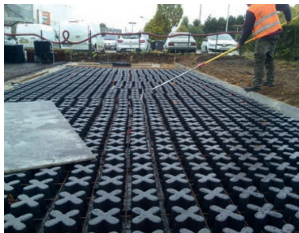
Photo 65 - Réalignement des moules (système Grasscrete®).
