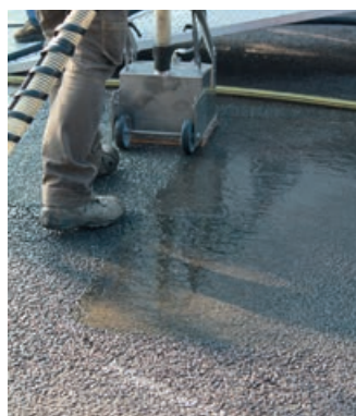
Photo 100 - Le nettoyeur aspire la boue produite.
