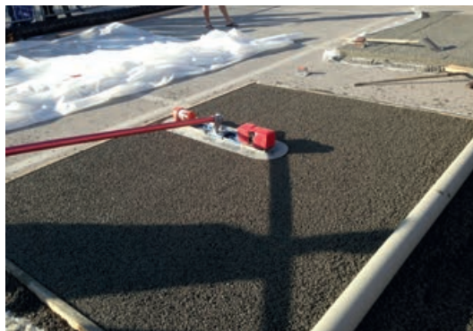
Photo 47 - Mise en œuvre du béton à la lisseuse vibrante.
