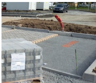
Photo 79 - Lit de pose en gravillons.
